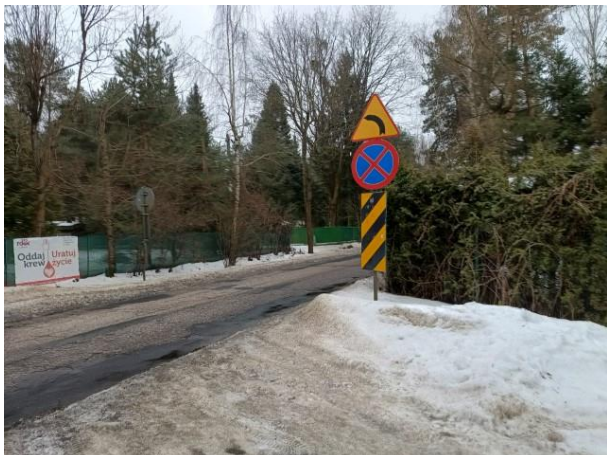
Widok drogi publicznej
